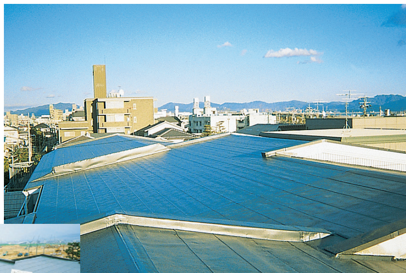
広島県 メゾンパークジャルダン 改修工事（色：ブラック）
