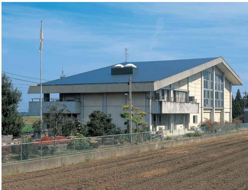
富山県 小杉町立池多公民館 改修工事（色：ブラック）
