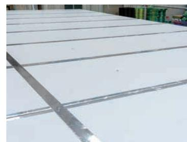
パネルジョイント部のアルミテープ貼り完了で仮雨養生が可能となり、階下作業（耐火被覆、土間コン打ち等）の準備が可能です。
