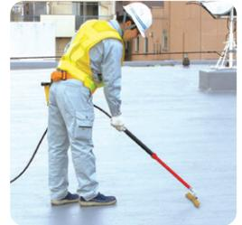
工事完了後やお引き渡し後に、防水層へ異常が見受けられた場合、専用の機械を使って、防水シートの穴開きがないか、検査をすることが可能です。
