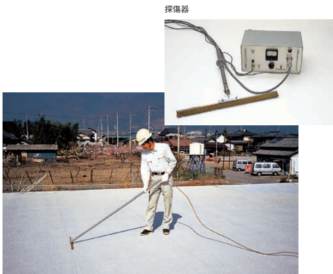
探傷検査作業
