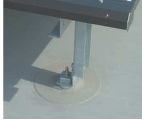
⑤ ソーラーパネルの設置
