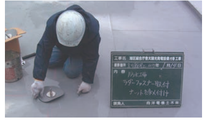
③ 防水シートの上に「防水アンカー」を設置
