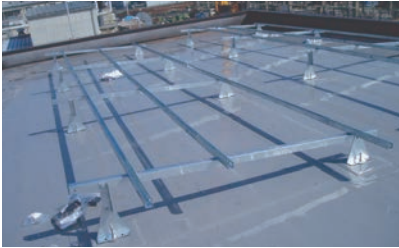
④ フレームの取り付け
