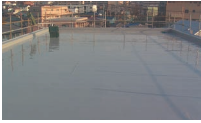
② 防水工事完了
