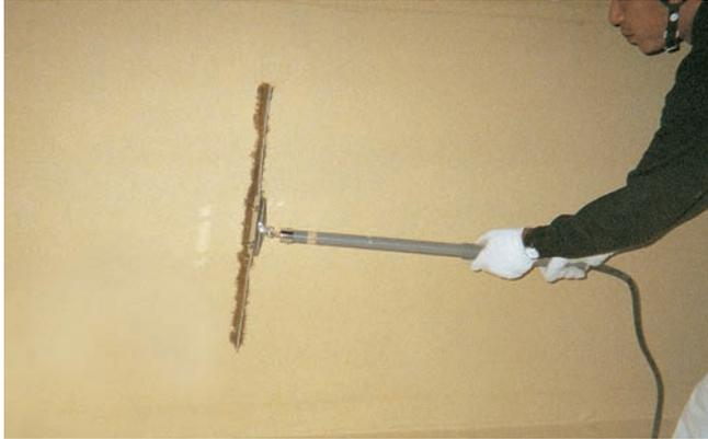
施工後の DN シート表面に高電圧をかけ、電気の放電現象を利用して DN シートの傷を安全かつ簡単に発見できます。
