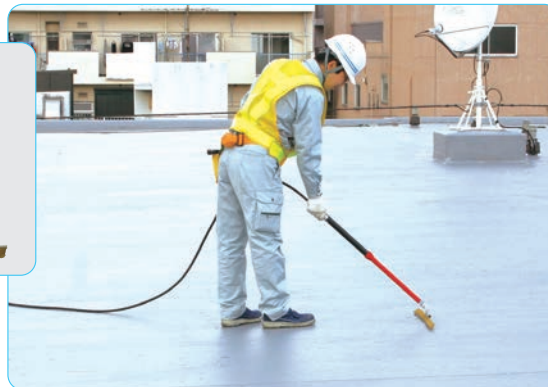
ピンホール検査作業
