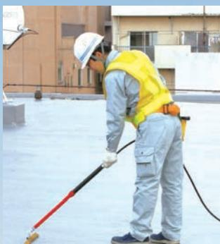
電気放電現象を利用した探傷器など科学的チェックシステムの導入により、施工後の検査がスピーディーに確実に行えるようになりました。このシステムは、その後のアフターメンテナンスにも応用し、お客様への的確なフォローを行っています。
