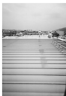
改修後（DN断熱防水）
