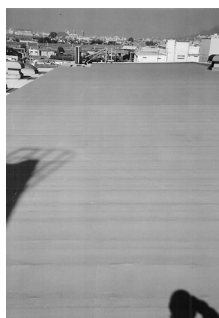
改修前（折板屋根）
