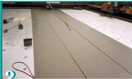
2 断熱材敷設、ディスク板取付
