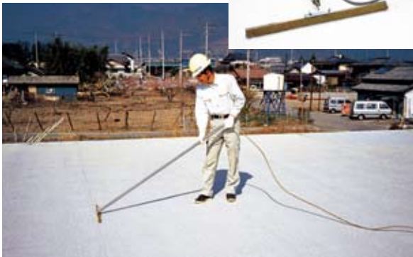
探傷検査作業
