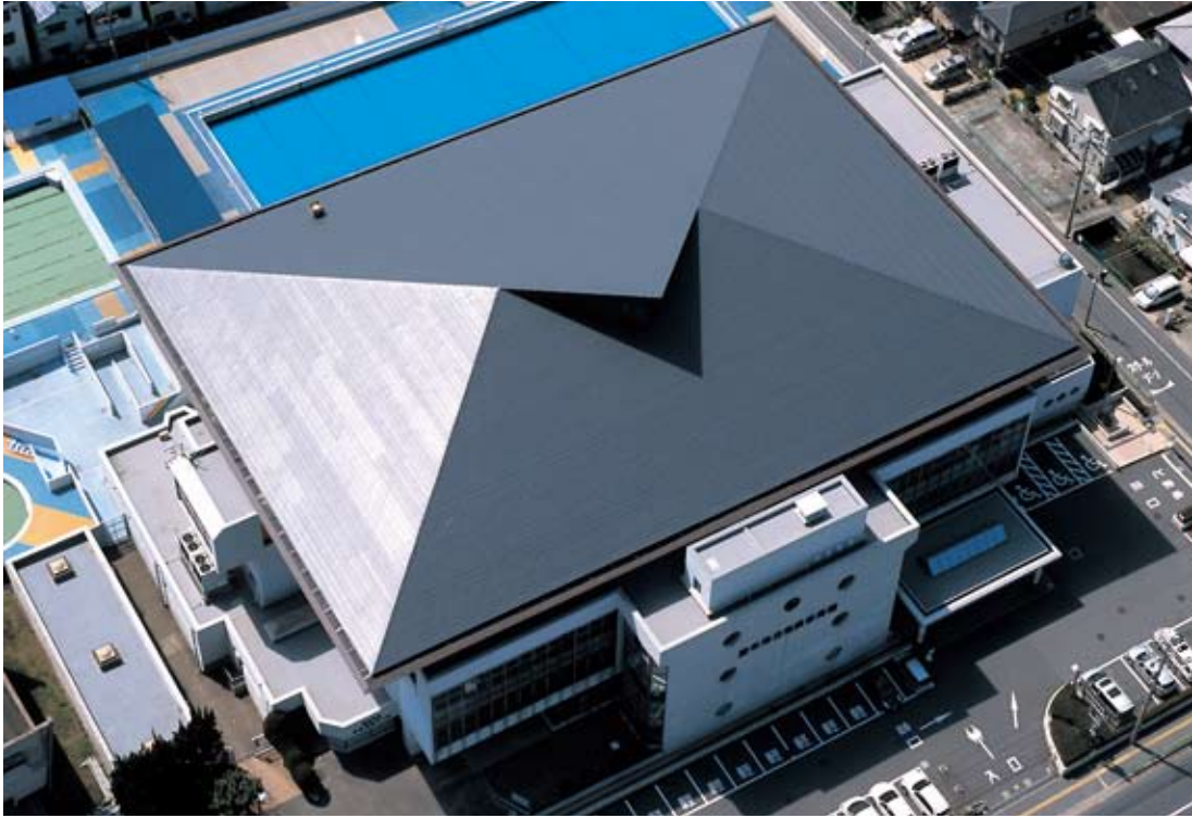
茨木市 茨木市市民体育館 改修工事（色：ブラック）
