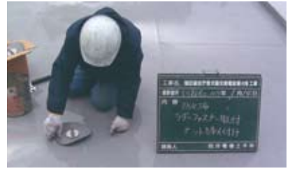
③ 防水シートの上に「防水アンカー」を設置
