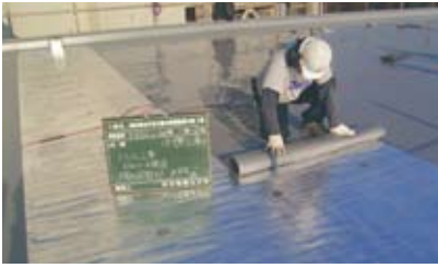
① 防水シート敷設
