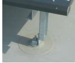
⑤ ソーラーパネルの設置
