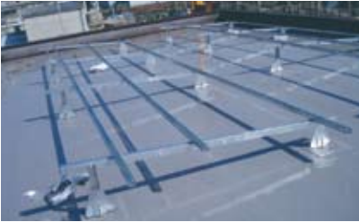
④ フレームの取り付け
