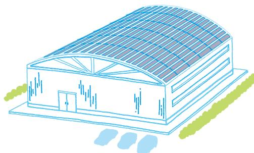
災害時の避難場所としても活用する体育館に、太陽光発電を設置する事は非常に有効です。しかし、屋内での運動を目的に建設されているため柱が少なく、屋根に大きな荷重を掛けることが出来ません。また、曲面屋根へ設置する必要があります。
